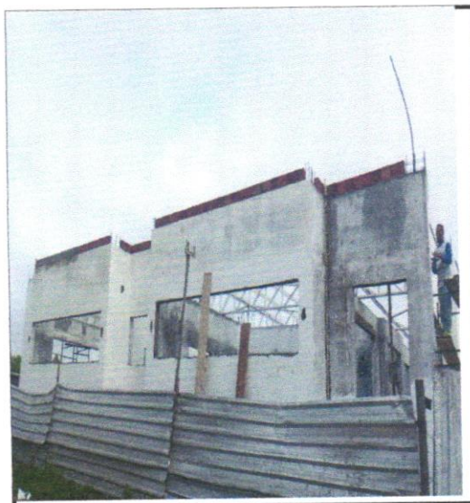
FOTO - 04 - ALVENARIA DE VEDAÇÃO COM ELEMENTO VAZADO DE CERÂMICA(COBOGÓ)
