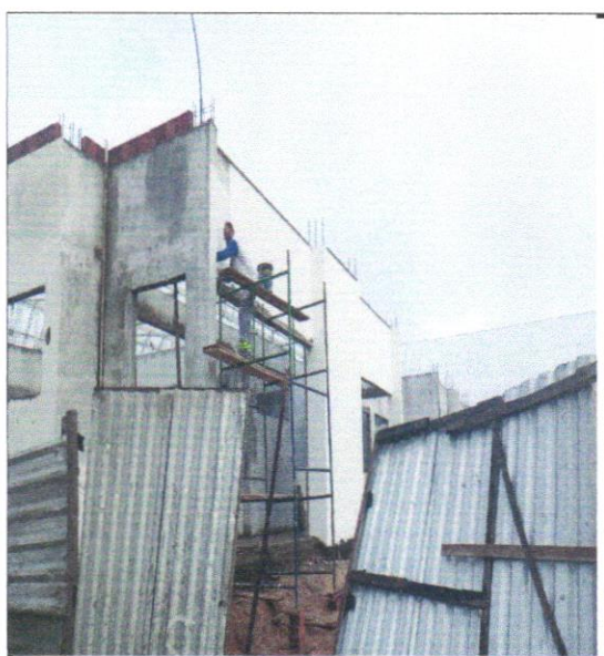
FOTO - 24 - APLICAÇÃO MANUAL DE MASSA ACRÍLICA EM PANOS DE FACHADA
