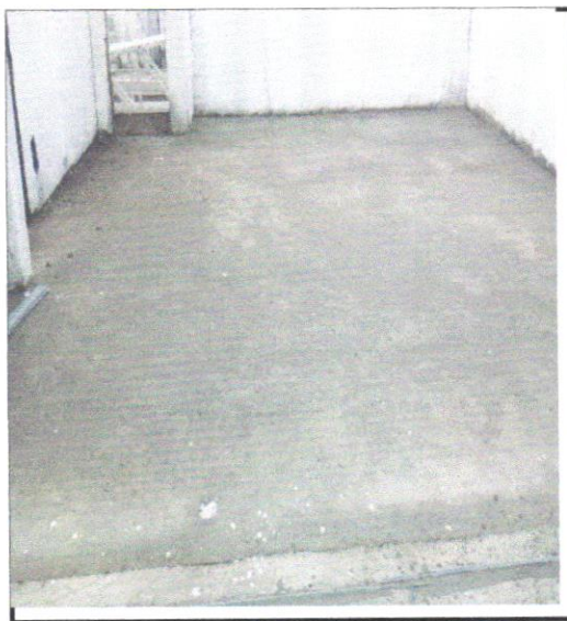
FOTO - 12 - Passeio em concreto
