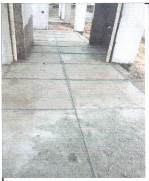
FOTO - 19 - Passeio em concreto desempenado com junta plastica a cada 1,20m espessura 10cm
