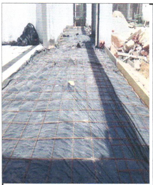
FOTO - 27 - Passeio em concreto
