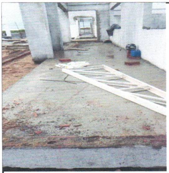
FOTO - 08 - Piso em concreto
