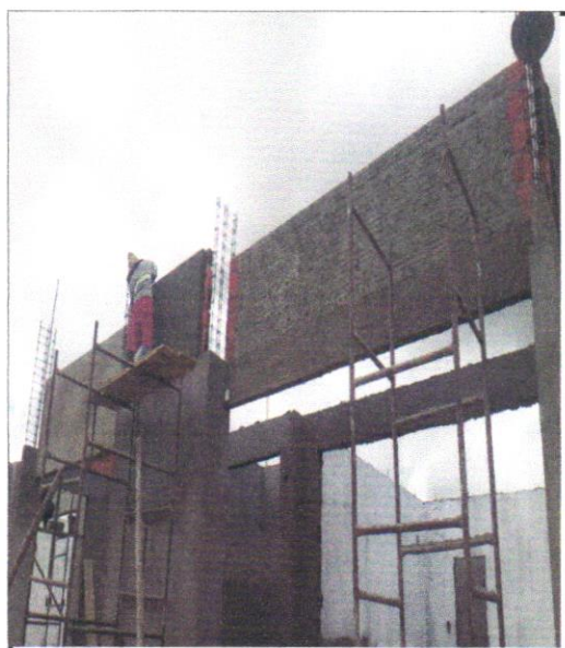
FOTO - 26 - EMBOÇO OU MASSA ÚNICA EM ARGAMASSA TRAÇO 1:2:8, PREPARO MECÂNICO
