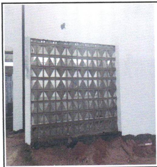
FOTO - 02 - ALVENARIA DE VEDAÇÃO COM ELEMENTO VAZADO DE CERÂMICA(COBOGÓ)
