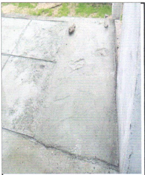
FOTO - 17 - Passeio em concreto desempenado com junta plastica a cada 1,20m espessura 10cm
