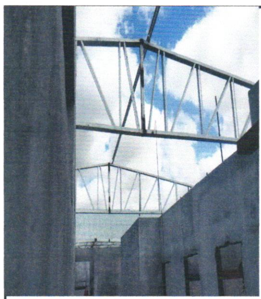
FOTO - 28 - TRAMA DE AÇO COMPOSTA POR TERÇAS PARA TELHADOS DE ATÉ 2 ÁGUAS PARA TELHA
