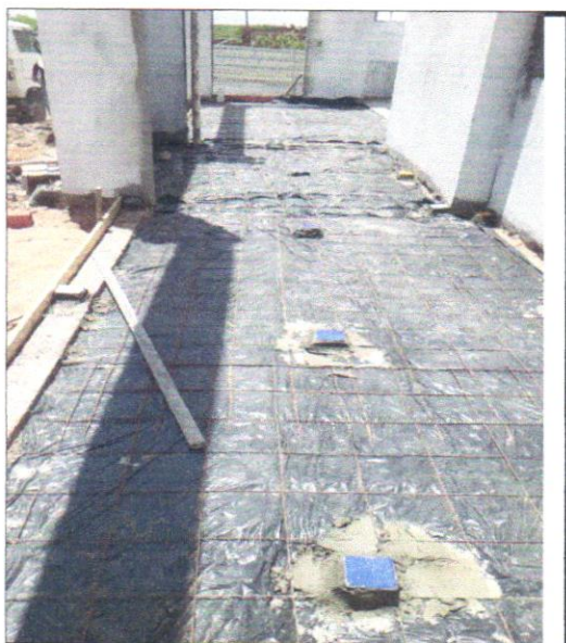
FOTO - 31 - Passeio em concreto
