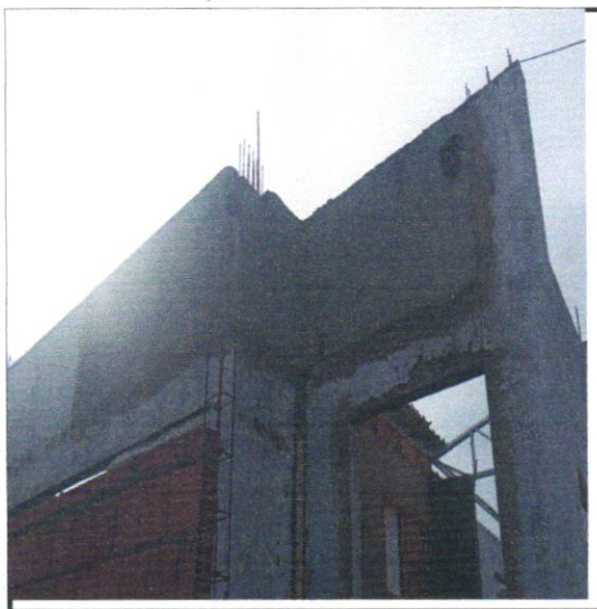
FOTO - 06 - MASSA ÚNICA, EM ARGAMASSA INDUSTRIALIZADA, PREPARO MECÂNICO, APLICADA COM EQUIPAMENTO DE MISTURA
