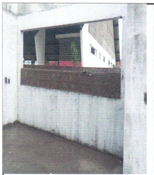
FOTO - 23 - EMBOÇO OU MASSA ÚNICA EM ARGAMASSA TRAÇO 1:2:8, PREPARO MECÂNICO
