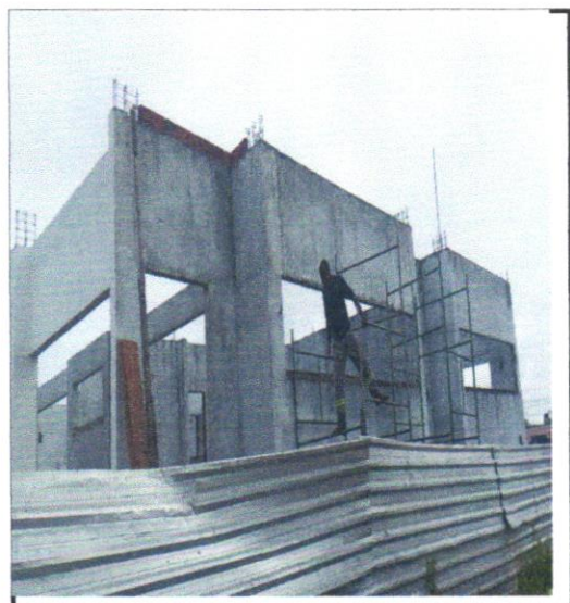
FOTO - 07 - ALVENARIA DE VEDAÇÃO DE BLOCOS CERÂMICOS FURADOS NA VERTICAL DE 14X19X39CM (ESPESSURA 14CM) DE PAREDES
