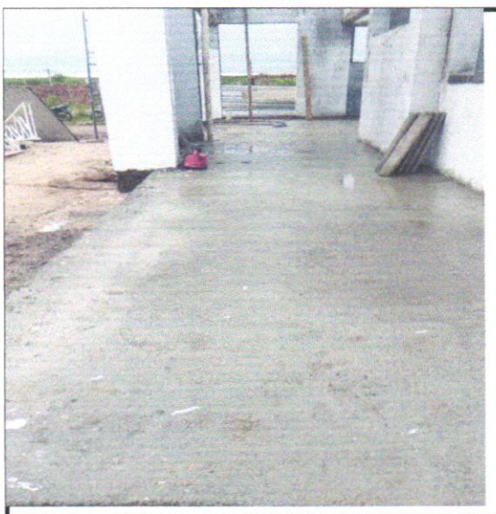
FOTO - 14 - CONTRAPISO EM ARGAMASSA TRAÇO 1:4 (CIMENTO E AREIA), PREPARO MECÂNICO COM BETONEIRA 400 L, APLICADO
